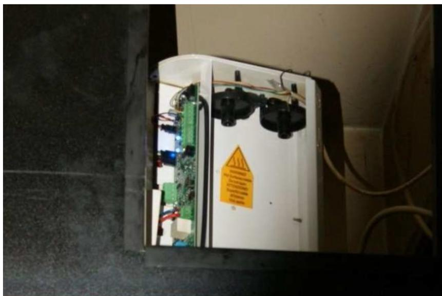
(Abb. 10: Eine Nebelgasanlage in einer Holzvertäfelung eingebaut)
