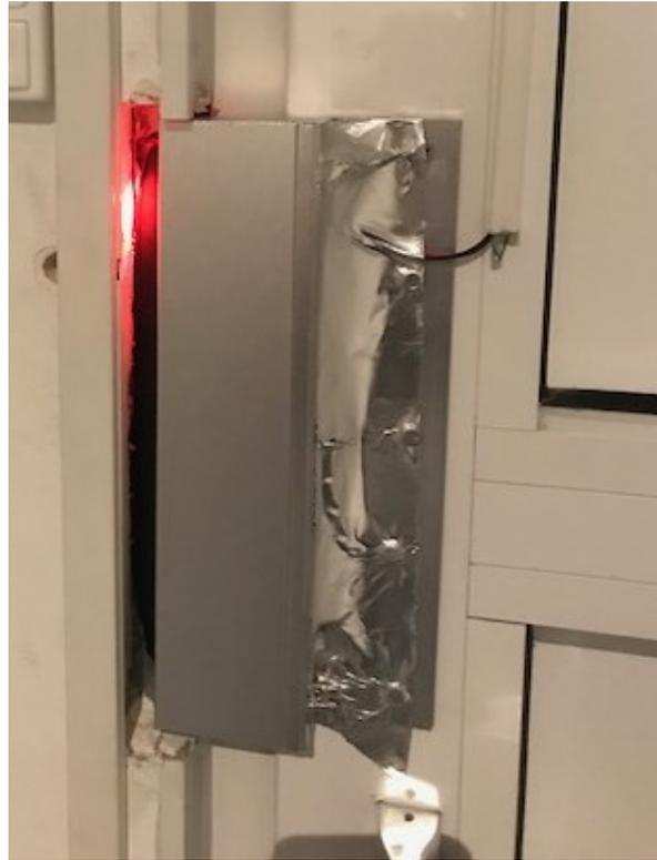
(Abb. 6: Fernbedienbares Magnetschloss)
