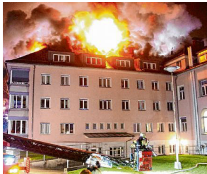
Die Schäden nach dem Brand vom 30. November sind so groß, dass das Weidachhof-Heim St. Josef abgerissen wird. Foto: zoom-tirol.at
