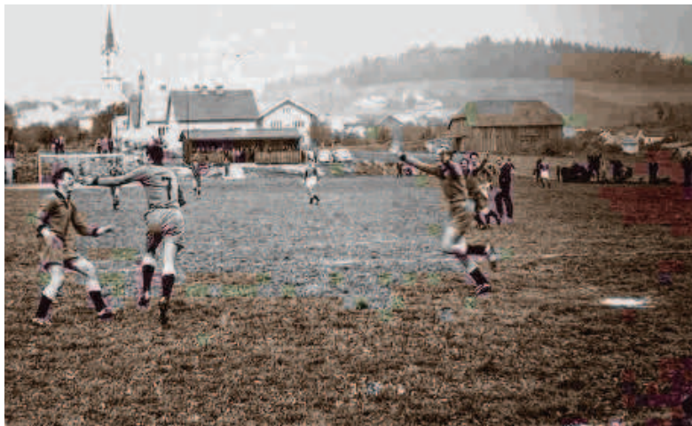
Am alten Sportplatz von Rohrbach-Berg - von hier aus sah man einst noch beide Kirchtürme.
